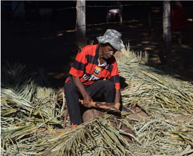
Preparo da folha de piaçava para fazer o telhado do Chapéu de Palha da comunidade. Crédito: APA-TO.
